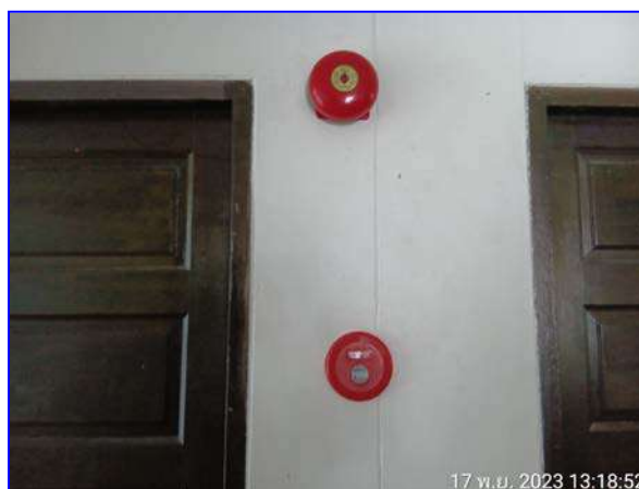
รูปที่ 2.31 สัญญาณแจ้งเหตุเพลิงไหม้
