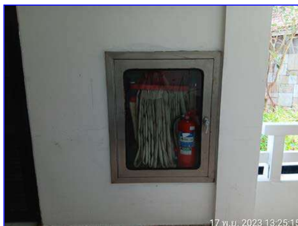
รูปที่ 2.28 ตู้เก็บสายฉีดน้ำดับเพลิง และถังดับเพลิง
